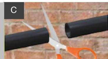
**C** Couper le tuyau à la sortie et fixer la vanne d'arrêt
